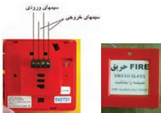
شکل ۱۰- شستی اعلام حریق با راهنمای فارسی
